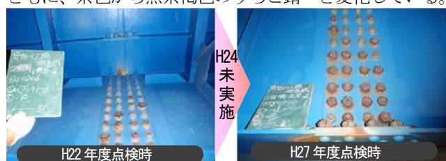
写真-4 腹板添接部
