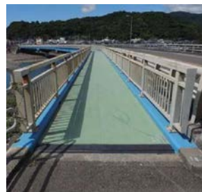
写真-2 現況写真
