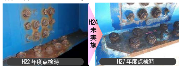
写真-5 主桁下フランジ添接部
