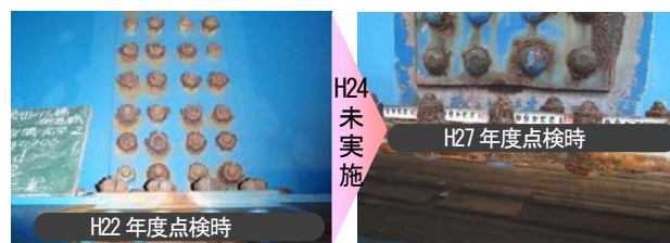
写真-6 高力ボルト部
