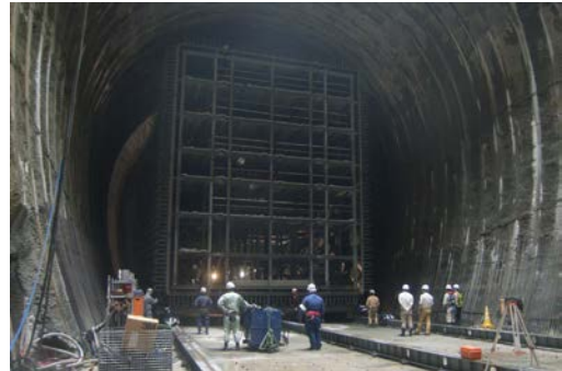
写真-3 トランジション管横引き作業（呑口部）
