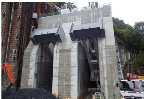
写真-2 吐ロゲート設備（下流側より撮影）
