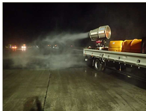
写真-7 強制冷却装置（ミスト散布）使用状況
