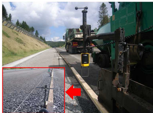
写真-3 センサーロープを用いた施工管理（一般的な例） ー他工事施工会社HPを加工ー
