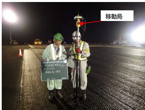
写真-4 移動局での高さ確認状況
