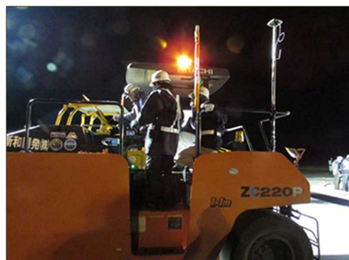
写真-5 転圧締固め管理システム 実施状況
