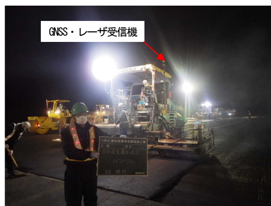
写真-2 システムを使用している舗設作業
