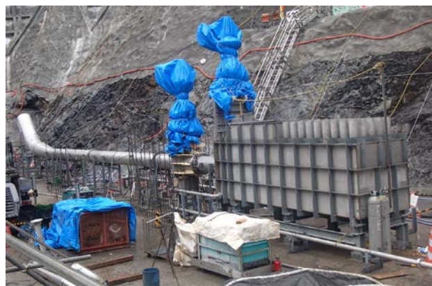
図-12 減勢工保護板の据付状況
