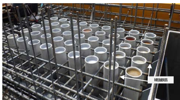
図-14 デフレクタの補強鉄筋設置状況
