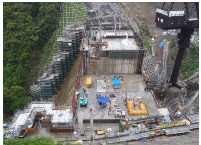
写真-5 施工状況（左岸天端から臨む）
