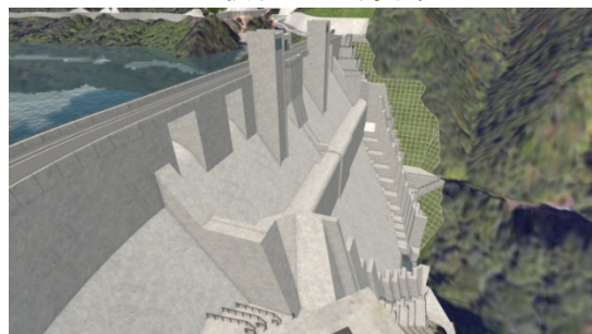
図-3 側水路減勢方式の減勢工（VR画像）
