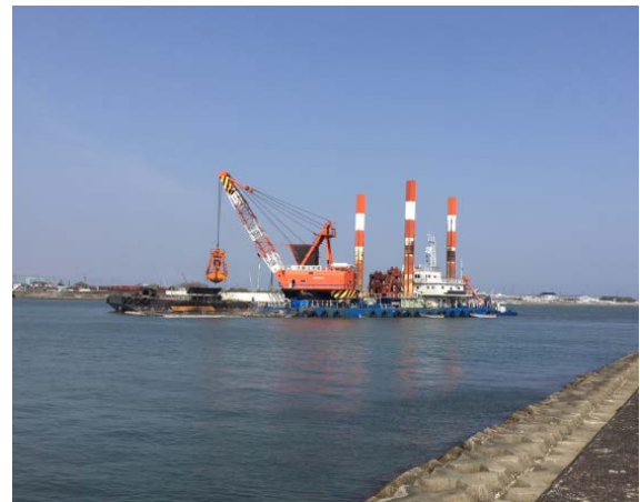
写真-7 新町川の浚渫状況
