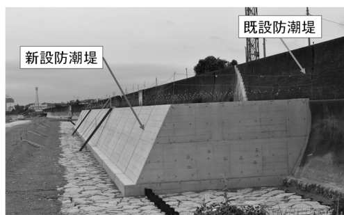
図-8 種崎外縁部施工状況（2018.6.14 撮影）
