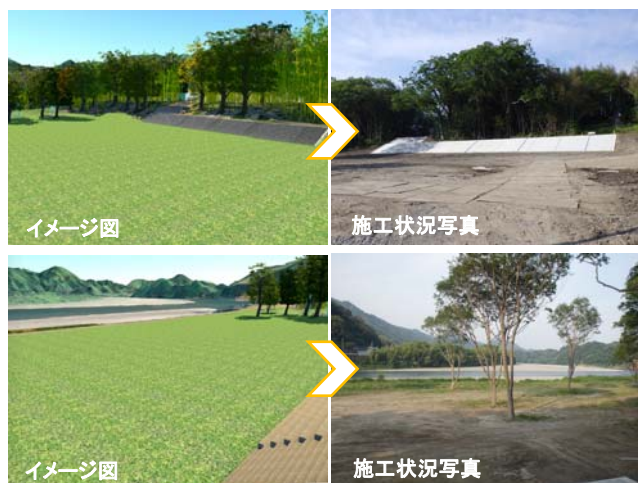
図-13 イメージ図と現地の施工状況
