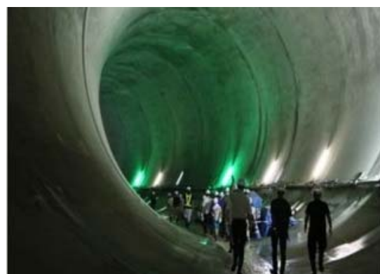
写真-3 トンネル洪水吐現場見学の様子
