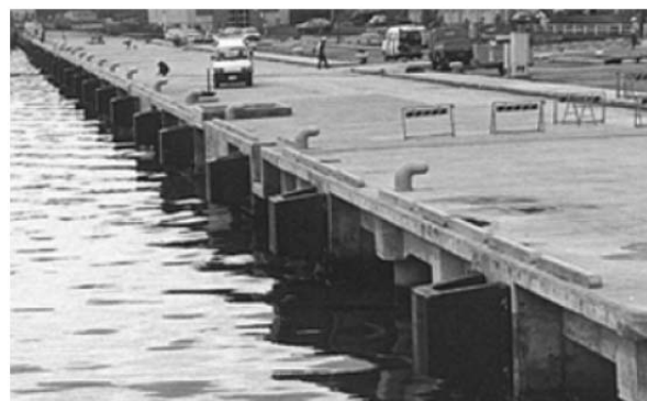
図一11 緩衝工の設置事例
