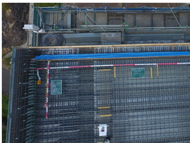
図-13 コンクリート打設前の鉄筋状況
