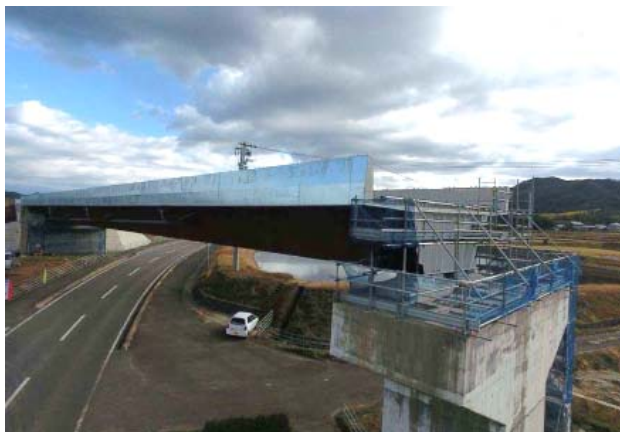
図-11 耐候性鋼材の表面の状態
