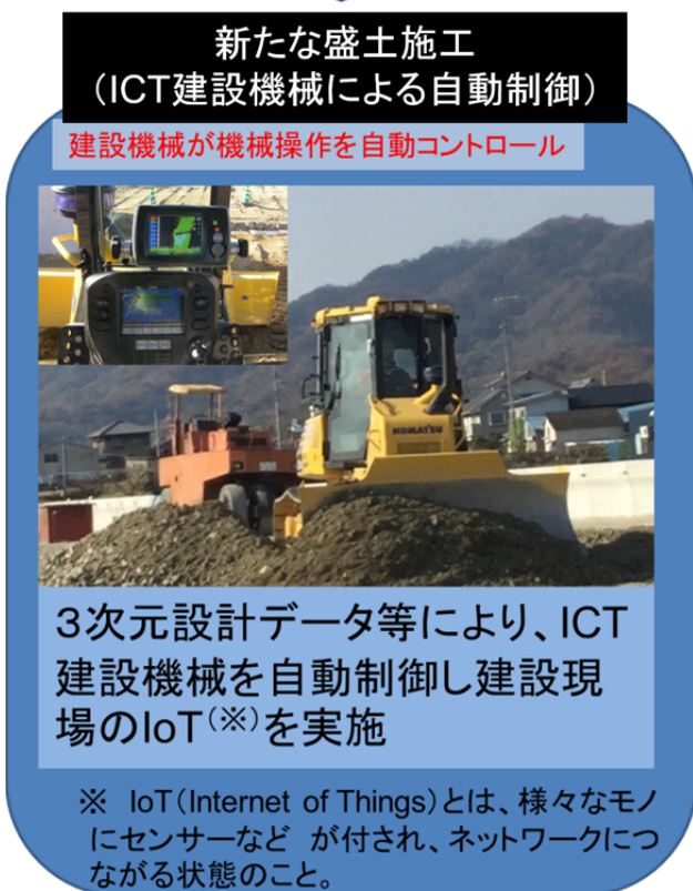
図-5 従来施工からICT建設機械施工へ
