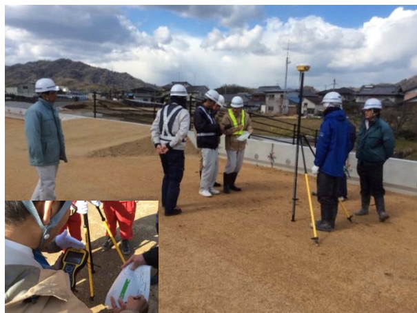
写-1 GNSSローパーによる実地検査状況
