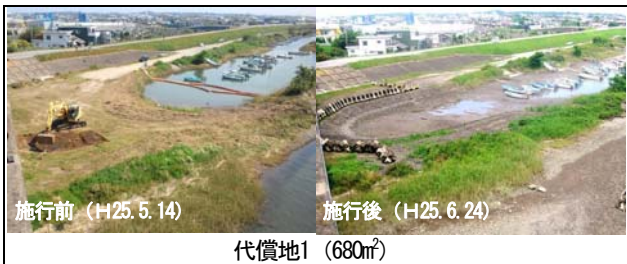
図-4.1 環境保全対策の実施状況(代償地1)
