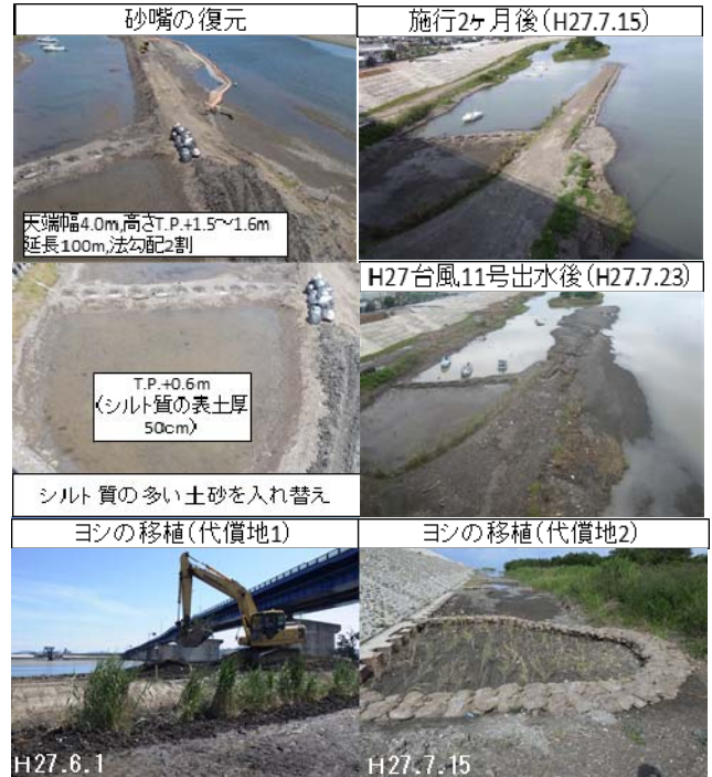
図-8 代償地創出箇所の改善状況
