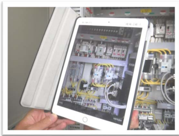
写真-5 現地での写真撮影状況
