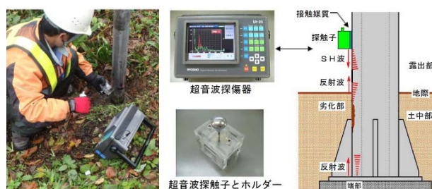
図-10 非破壊試験金属劣化判定による調査
