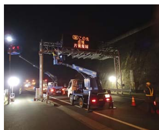
写真-1 門型標識等点検状況
