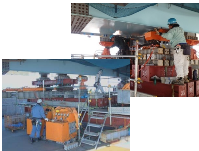
写真4. 高さ調整状況
