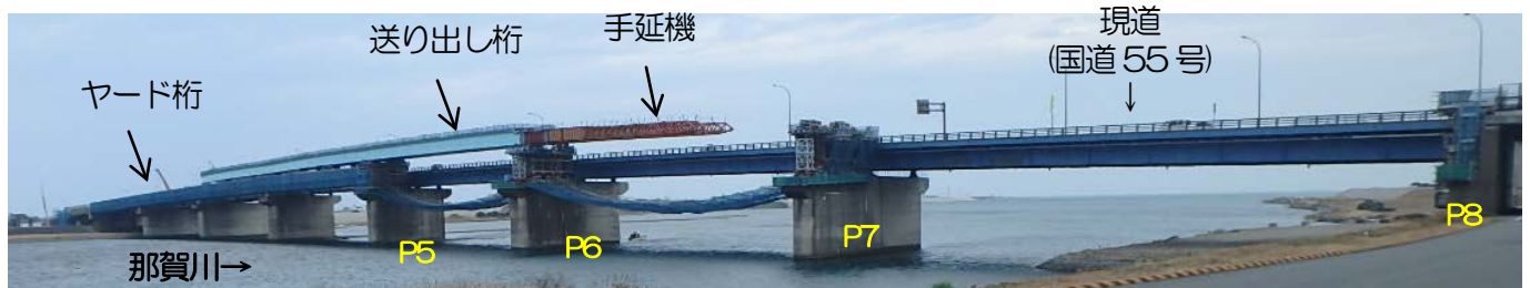
写真-1. 送り出し状況
