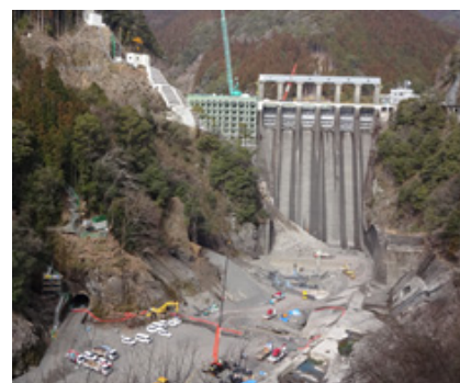
写真2 長安ロダム改造事業 (徳島県那賀町)
