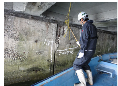
写真8 構造物の点検状況
