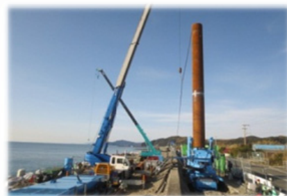
写真1 高知海岸耐震・液状化対策事業 (高知県高知市ほか)
