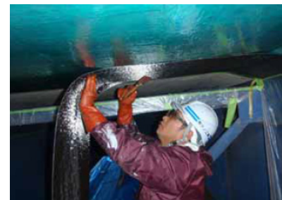
写真9 橋梁の修繕状況
