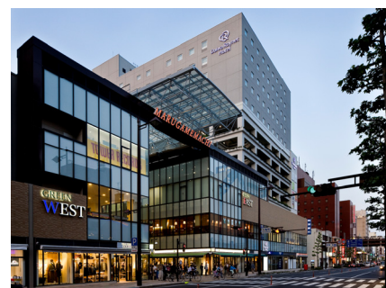
写真3 丸亀町商店街再開発 (香川県高松市)
