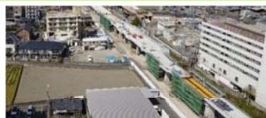
【高架区間工事状況】
