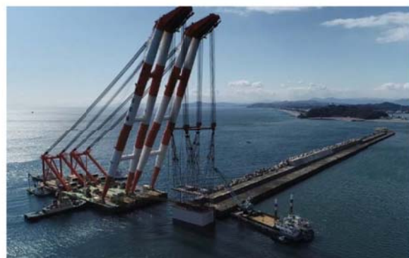
【ケーソン据付状況】
