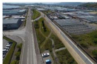
【高知港海岸 進捗状況】
