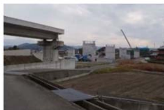
【南国安芸道路 進捗状況】
