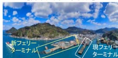
【八幡浜港工事状況】
