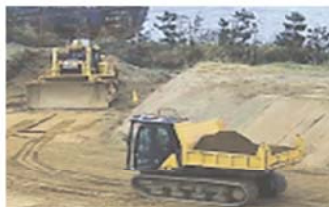
5G等を活用した無人化施工
