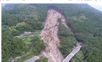
図2 寸断された高速道路
