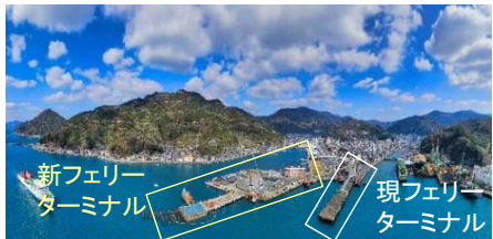
【八幡浜港工事状況】
