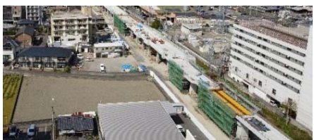
【高架区間工事状況】
