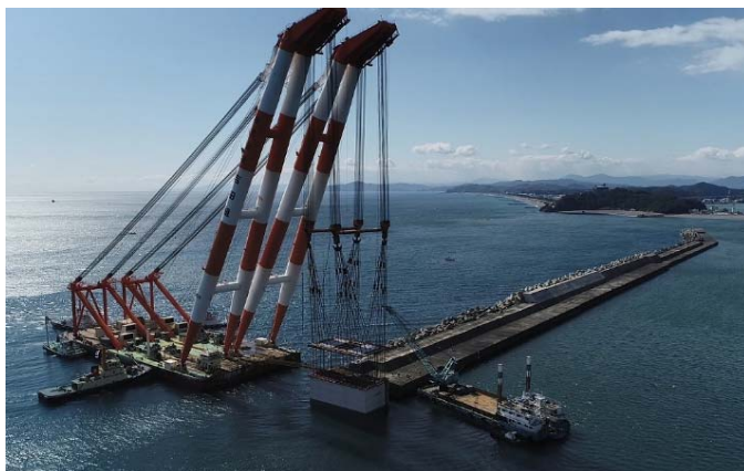
【ケーソン据付状況】
