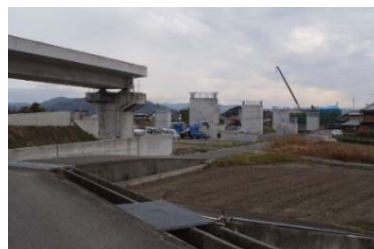
【南国安芸道路 進捗状況】
