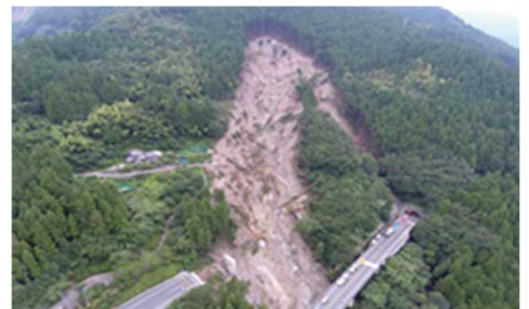
図 3 平成 30 年 7 月豪雨により寸断された高速道路（高知県 大豊町）
