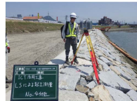
レーザースキャナー(TLS)による起工測量
