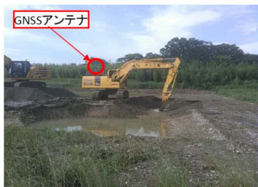
MCバックホウによる掘削状況
