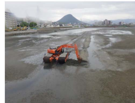
掘削状況(泥上掘削機)(マシンガイダンス)
