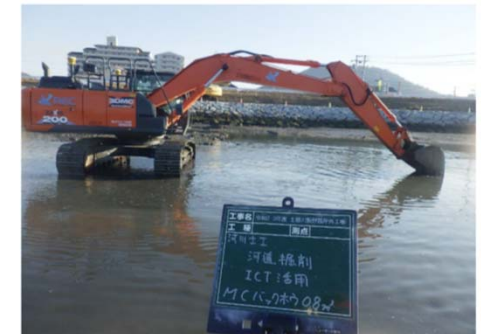
掘削状況(従来機)(マシンコントロール)
