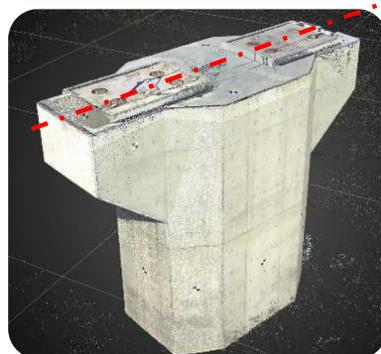
出来形評価は取得した点群データから構造物の寸法を算出し評価します。
