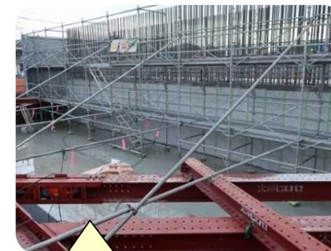
足場などの障害物がある場合の検証点の設置位置は、TS及びTLSの計測位置から検証点と基準点が計測できるかを事前に確認しておきます。
