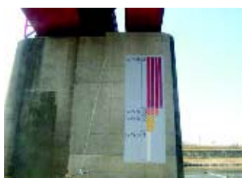
水位表示の例（橋げた）
