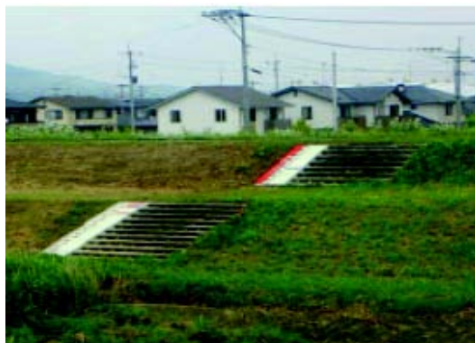
水位標の設置
