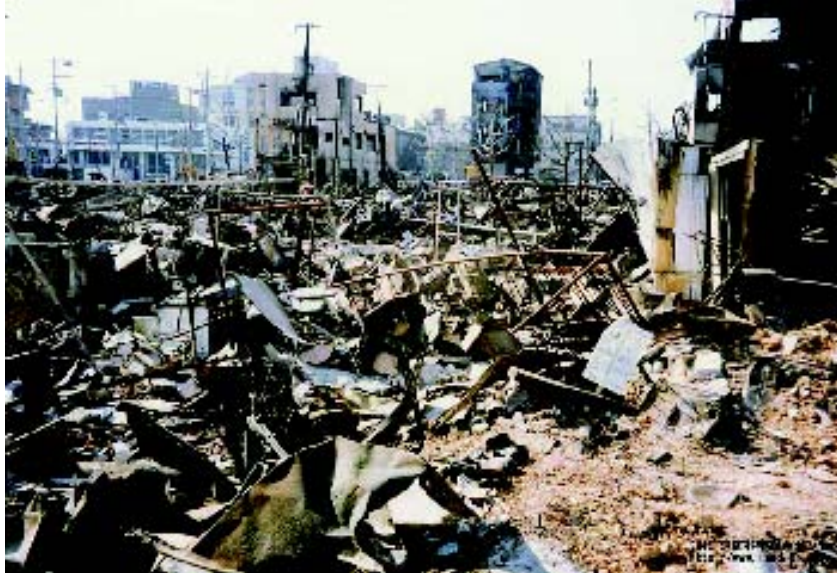
写真：消防科学総合センター
