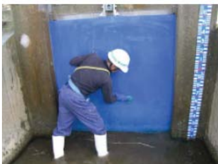
樋門ゲートの点検
