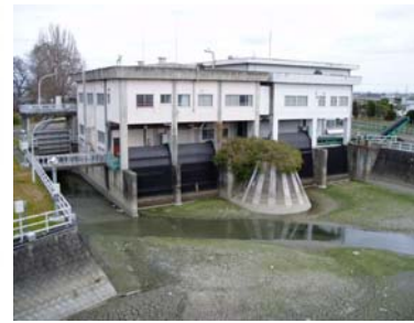
神宮入江川排水機場 （石井町）
