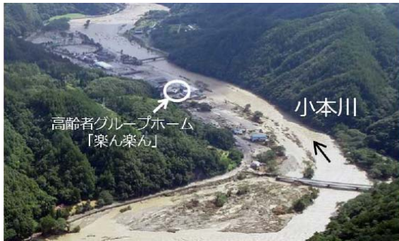
小本川周辺の浸水状況
