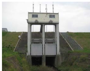
城の谷樋門（美馬市）
