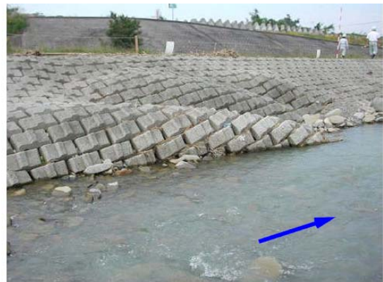
護岸被災状況 （土器川西側河口より9.4km付近）
