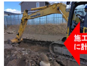
②3D-MG施工 + ②刃先による計測
