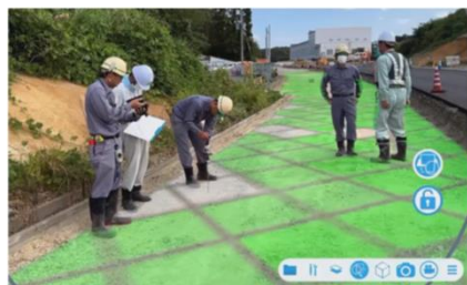
ARを活用した土工の出来形確認
