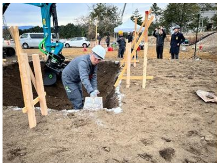
手元作業員が多い現場
