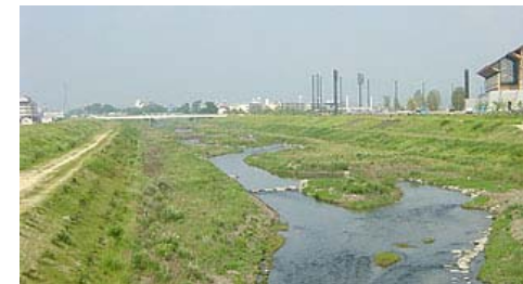
在来植生を使ったコンクリートの見えない川づくり
