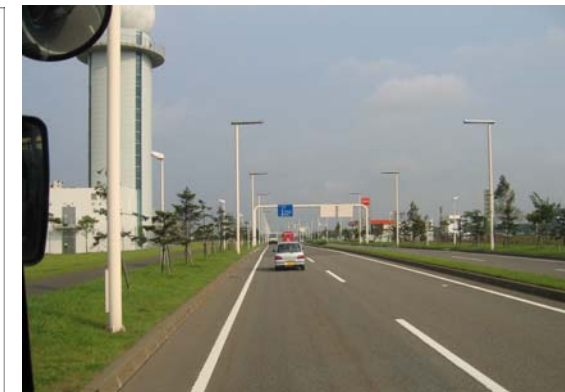
ガイドライン対象箇所 （国道36号 新千歳空港付近）
