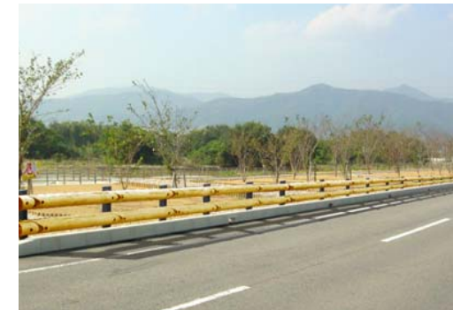
周囲の景観になじむ木製の防護柵（徳島県）
