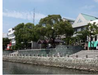
新町川の自然石による 護岸整備
