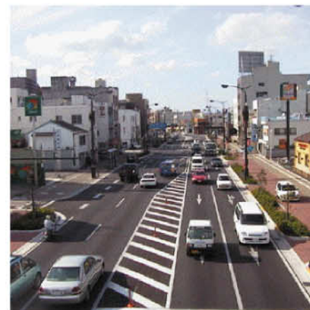
電線類の地中化事業(徳島県・徳島市)
