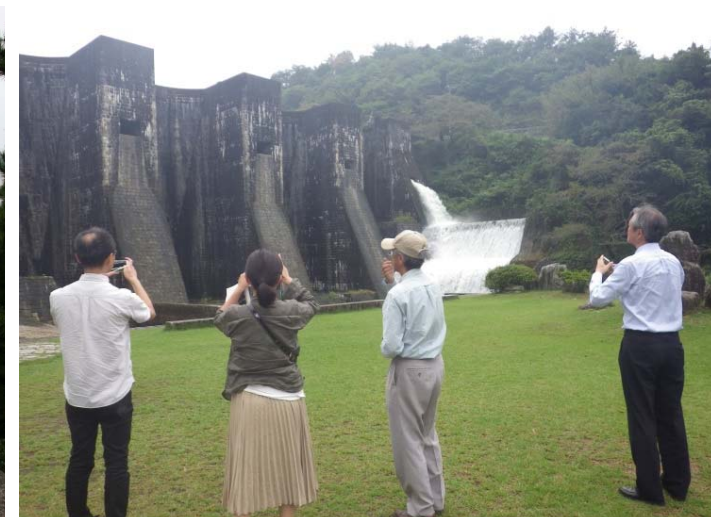
豊稔池堰堤(観音寺市)
