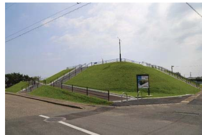
小松島ニュータウン地区津波避難施設
