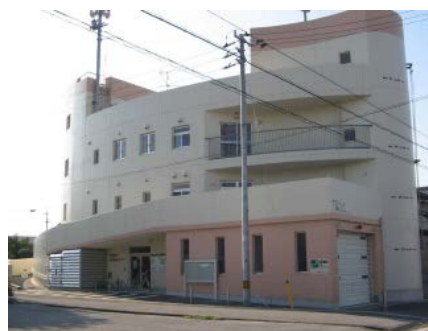
種崎地区津波避難センター
