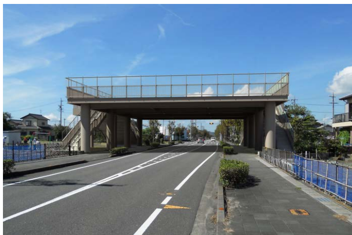
静岡県吉田町の津波避難タワー
