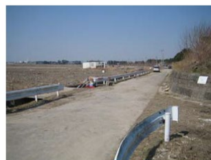
◇仙台東部道路より陸側（西側）
