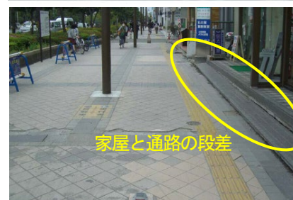
液状化による被害状況 (東日本大震災：千葉県浦安市)
