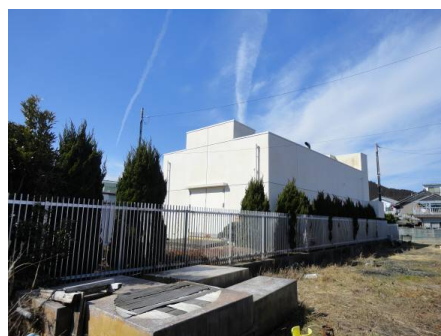
寺前ポンプ場
