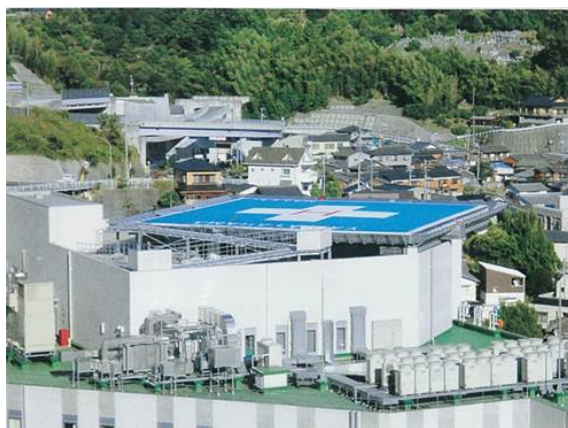
屋上ヘリポート
