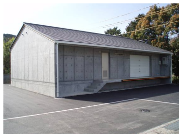
町所有の備蓄倉庫
