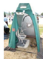
『災害用マンホールトイレ』 (愛媛県八幡浜市保内中学校に配備)
