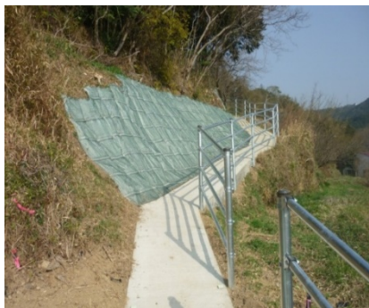
夜須町出口【城山避難道】
