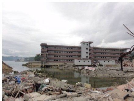
津波避難ビル周辺が地盤沈下 (東日本大震災：南三陸町)
