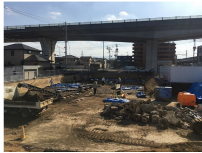
▲駅前広場整備箇所から、埋蔵文化財が出土したため、発掘調査を行う。
