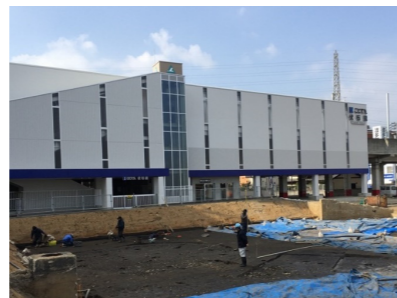
▲駅舎整備工事の様子
