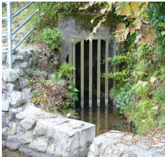
野村成満が開削した旧の水路トンネルの出口
