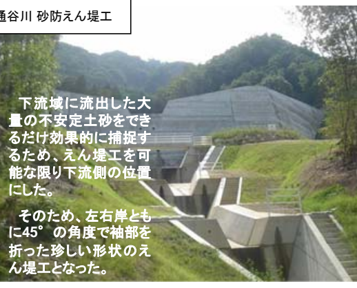
通谷川 溪流保全工 急峻な地形のため、溪流保全工の延長L=419mのうち、落差工が20箇所ある。
