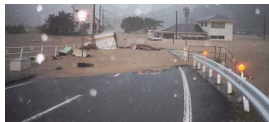
豪雨災害により水没した下川口
