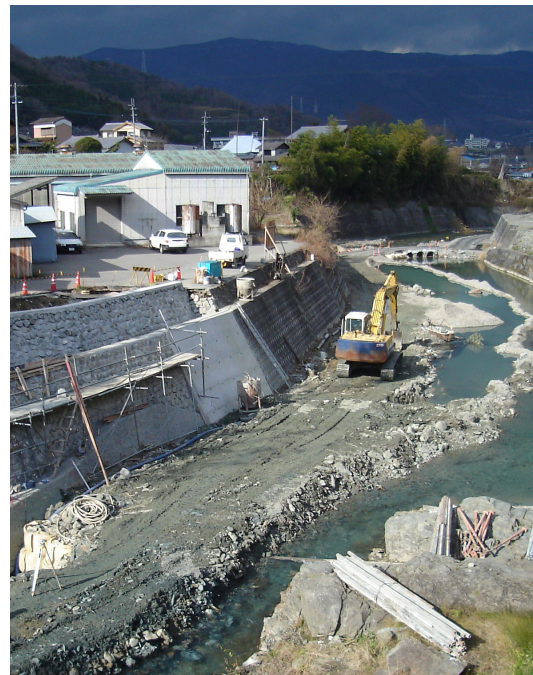
災害復旧工事
