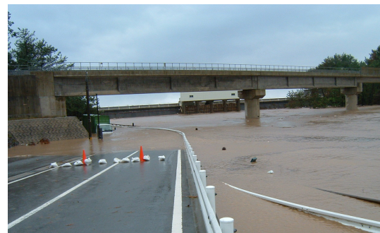
水門付近冠水状況
