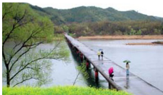
最下流にある佐田沈下橋の春の風景
