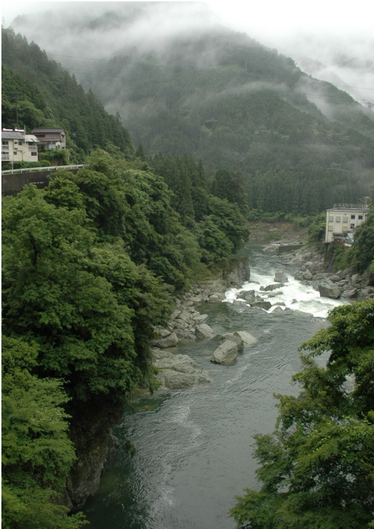
村道長沢川口線吉野川橋から吉野川下流を望む
