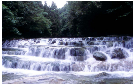
改修された正体下堰
