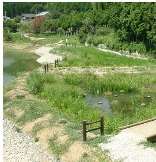
完成したビオトープ
